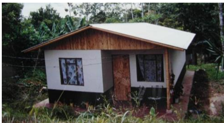
Figura 3. Vivienda del proyecto Nacional de Bambú 7
