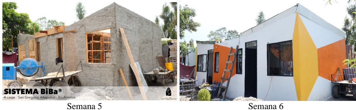
Figura 7. Proceso constructivo de 4 viviendas en Xochimilco (Ciudad de México, 2018) 8 .
